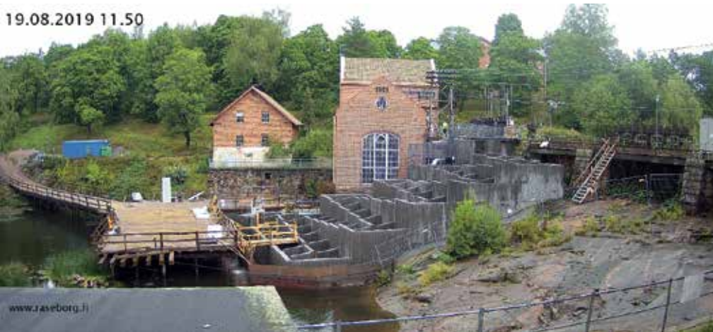
Karjaanjoen vesistön alaosalla, Mustionjoessa, on neljä voimalaitospatoa, joista kahteen on rakenteilla kalatiet. Kalatien rakentamisen edistymistä voi seurata Raaseporin kaupungin sivuilta osoitteessa https://www.raasepori.fi/kaupunki/webcam/kalatie/
